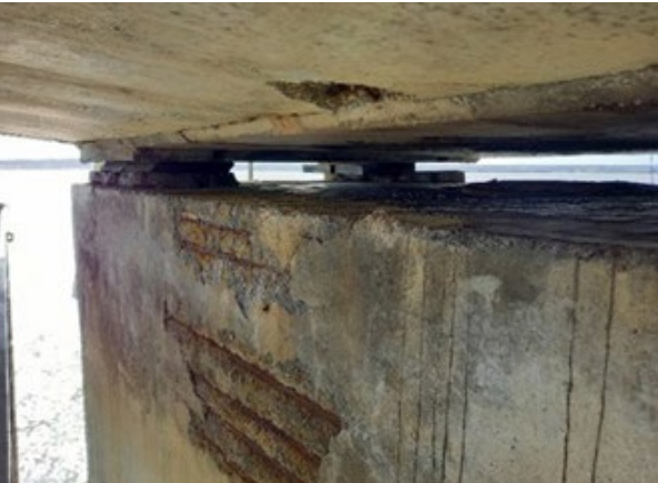
Pile 17 : cheminement des appareils d'appuis
