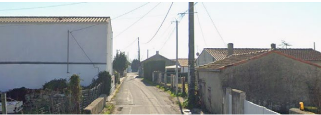
Rue des Cotines à Ors sur un des itinéraires de shunt empruntés en haute saison : voirie non adaptée à une forte circulation
