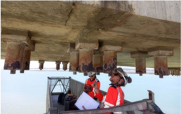
Inspection de la sous face du tablier par nacelle négative*
