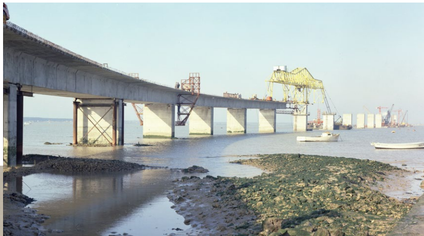
Il aura fallu 18 mois pour monter l'ensemble du tablier.
