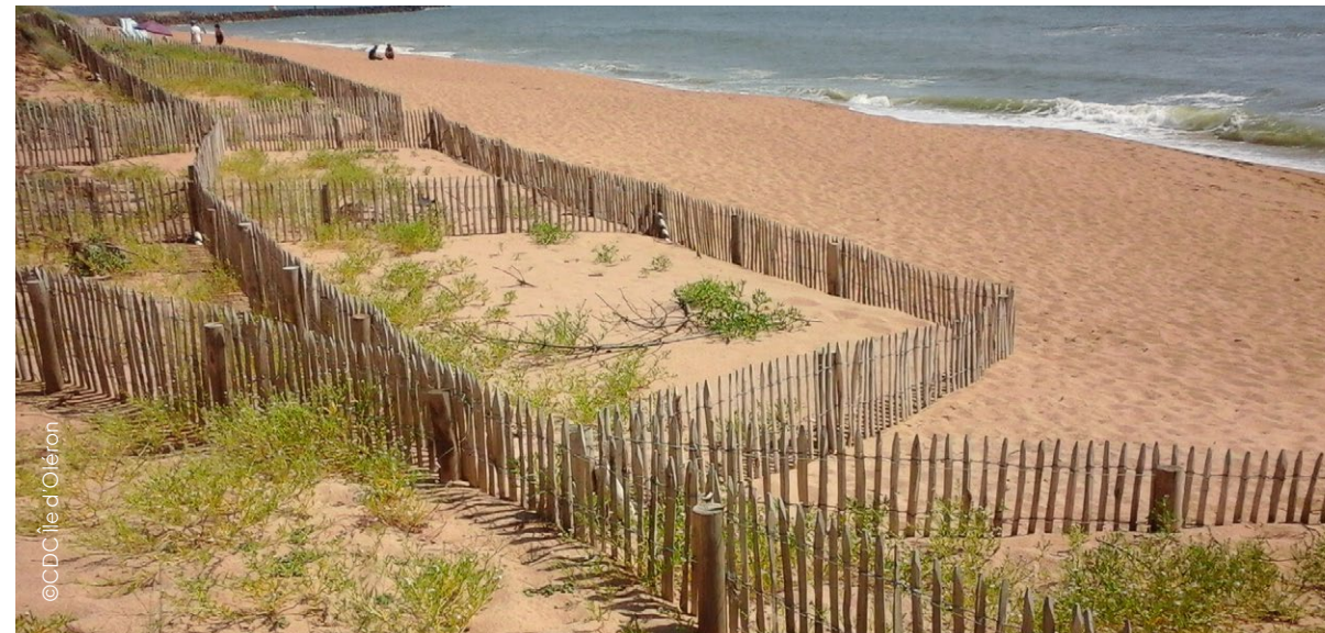
Installation de ganivelles en haut de plage de la Cotinière permettant la fixation naturelle du sable et la protection de la végétation. Chantier réalisé sous maîtrise d'ouvrage de la Communauté de Communes avec un financement de 30 % du Département
