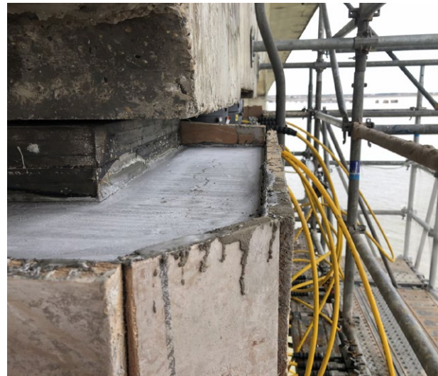
Exemple de reconstruction de bossage en béton et de remplacement d’appareil d’appui
