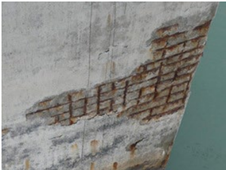
Pile 8 et pile 14
