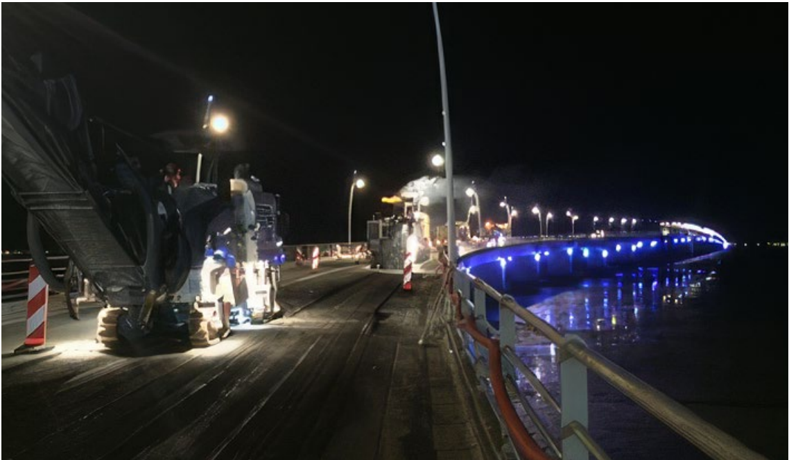
Photo chantier de réfection de l’étanchéité Avril-Mai 2017
