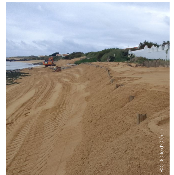
Protection des habitations par déplacement et façonnage du haut de plage. Chantier réalisé sous maîtrise d'ouvrage de la Communauté de Communes avec un financement du Département
