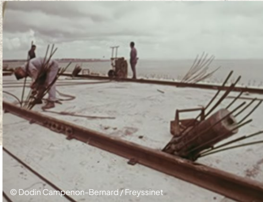
Mise en œuvre précontrainte de solidarisation.
