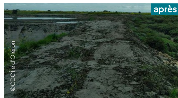
Reprise et confortement de berges en cours pour assurer la bonne circulation de l'eau - Chenal du Saillant à St-Trojan-les-Bains sous maîtrise d'ouvrage de la Communauté de Communes avec un financement du Département.
