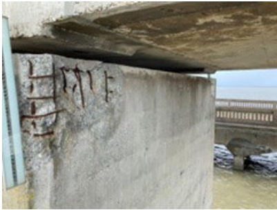
Pile 44 et pile 38
