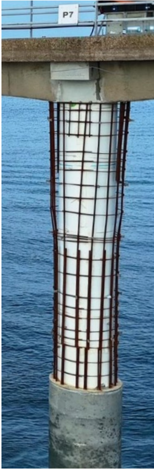
Mise en place des armatures
