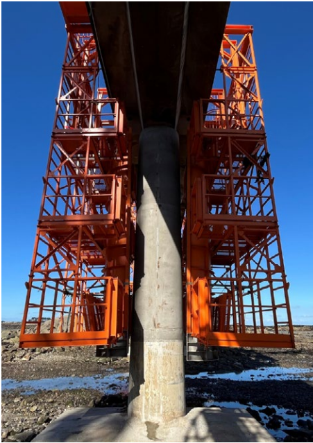
Après mise en place du béton, la pile est réparée
