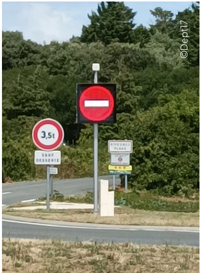
Exemple de signalisation dynamique, à l'entrée de la rue Défend, principale voie de « shunt » à Rivedoux-Plage. Dans les situations de trafic « normal » le panneau est éteint. Il s'allume avec les premiers ralentissements mesurés par ré-info-traffic.fr.
