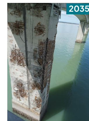
Évolutions de la pile 17 (faces Est et Sud) de 2026 à 2031 et 2035 (projection)
