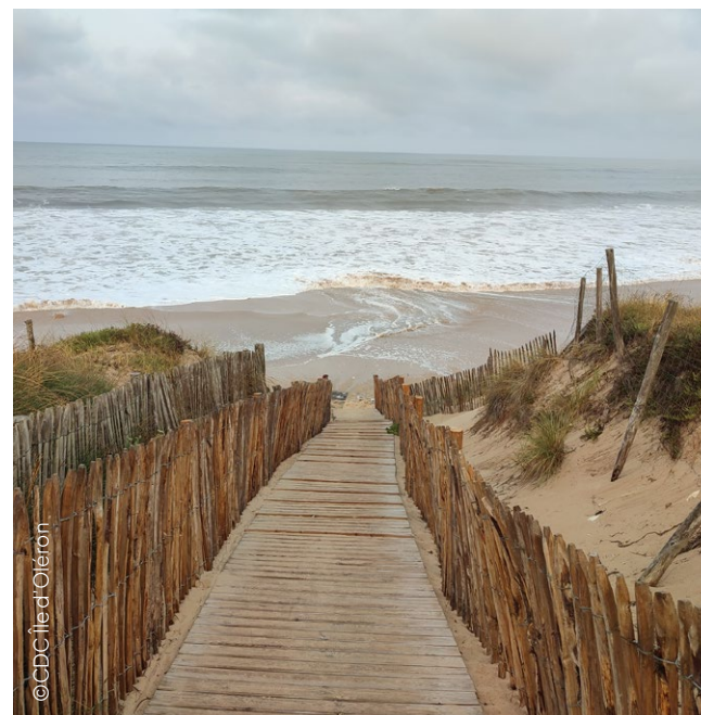
Réalisation d'un cheminement d'accès pour éviter le piétinement de la dune Passe du Treuil
