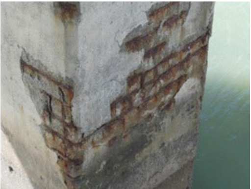
Pile 3 et pile 7
