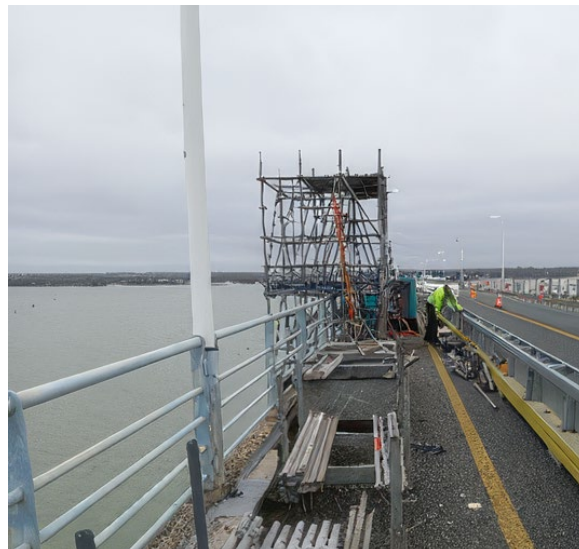
Chantier sur le pont
