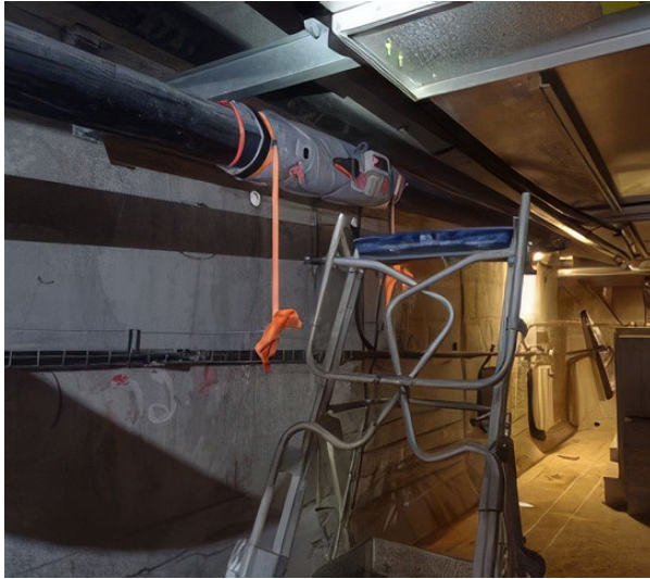
Photos contrôle intérieur gaine de précontrainte par thermographie
