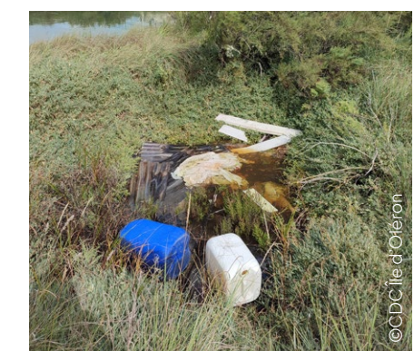
En l'absence d'un entretien régulier, la fermeture des milieux et la multiplication des dépôts sauvages entraînent une dégradation du fonctionnement hydraulique des marais
