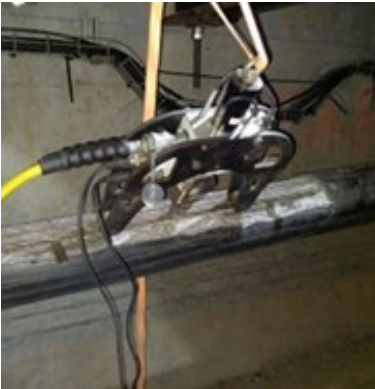
Contrôles de la tension dans les câbles de précontrainte intérieure et extérieure par essais à l'arbalète
