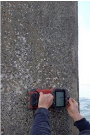
Méthode non destructives : détection armatures béton et épaisseur enrobage à gauche, et évaluation degré de corrosion par la méthode de mesure de potentialité
