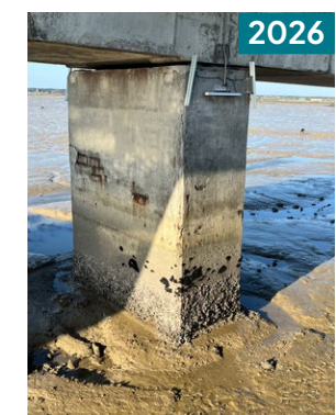
Évolutions de la pile 39 (faces Est et Sud) de 2026 à 2031 et 2035 (projection)
