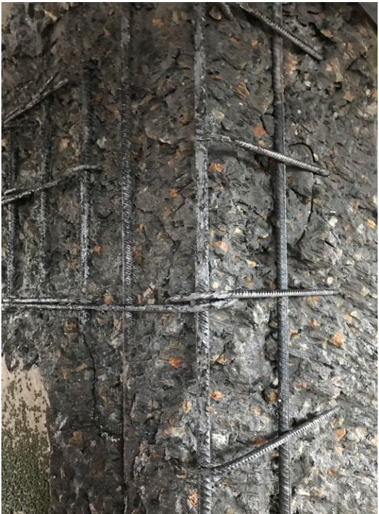
Étape n°1 : purge du béton par hydrodémolition
